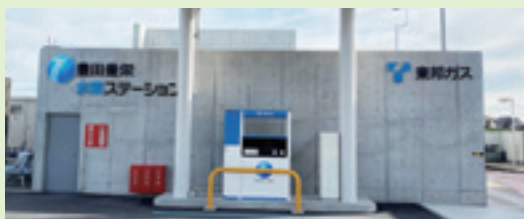
豊栄スタンド水素ステーション
